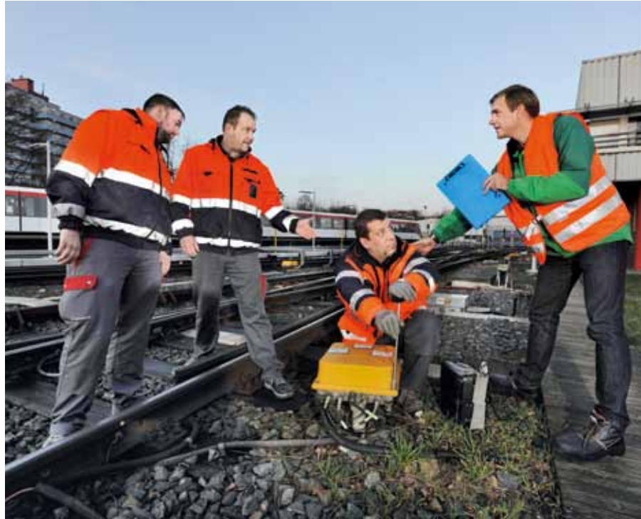
Direkt dort, wo die Kollegen arbeiten, wird gecoacht: Martin Sturm (r.) berät (v. l.) Andreas Rebs, Holger Zimmermann und Dennis Luther.
